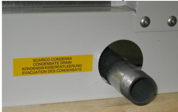
Abb. 9 Anschluss an das Kondenswassersammelbecken
