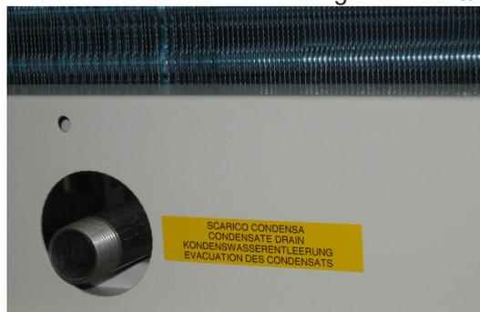
Abb. 10 Anschluss an das Kondenswassersammelbecken
