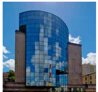
JAPAN HOUSE (MOSKAU, RU) „BREEAM Gut“
